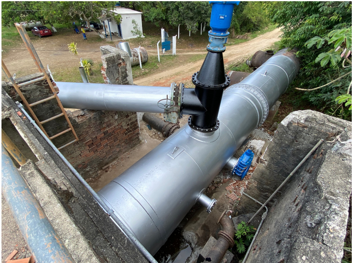
Intervenção de Manutenção Preventiva realizada na Adutora de Água Bruta DN 1600mm do Sistema Tapacurá | 2021
