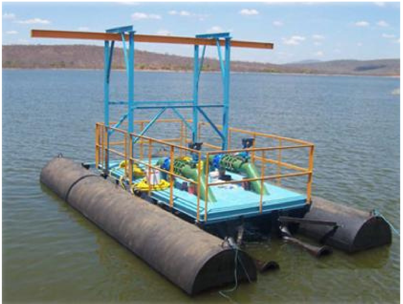
Captação Flutuante fabricada em aço carbono, Uiraúna/PB
