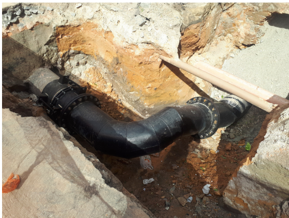
Interligação Saída da Estação de Bombeamento
