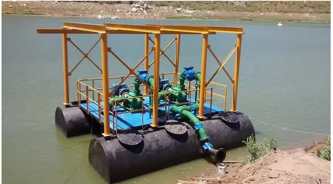
Captação Flutuante fabricada em aço carbono, Aroeiras/PB
