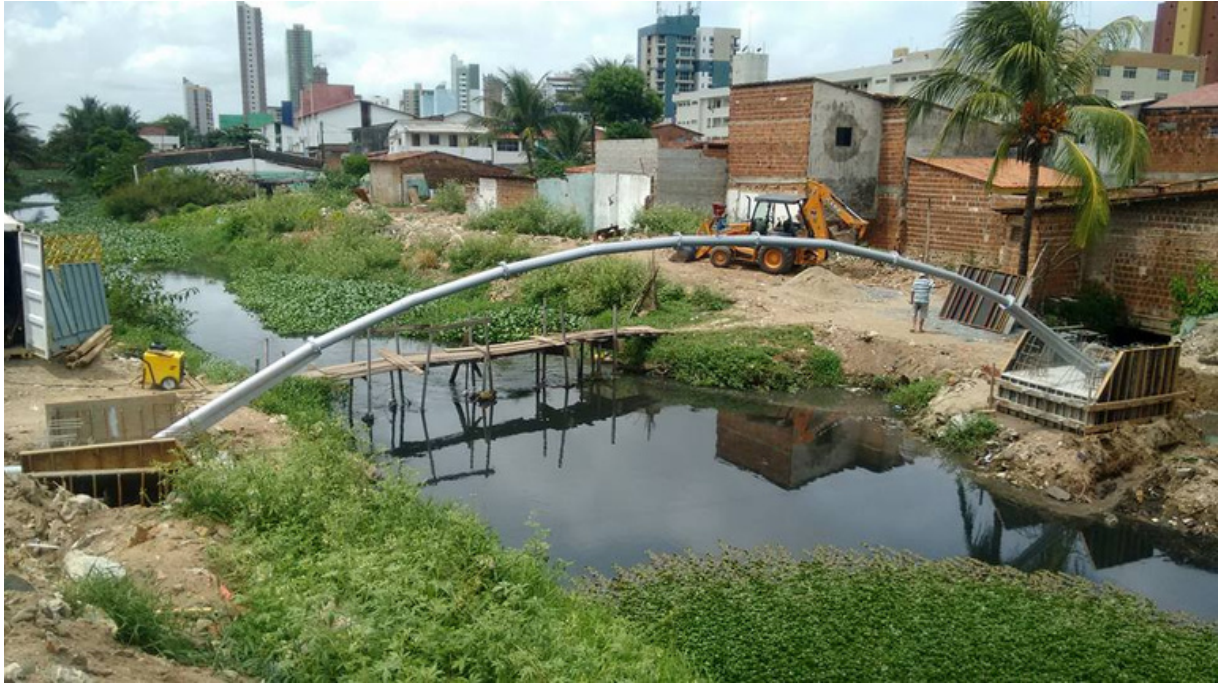
Travessia Aérea em Arco DN 150mm | João Pessoa/PB
