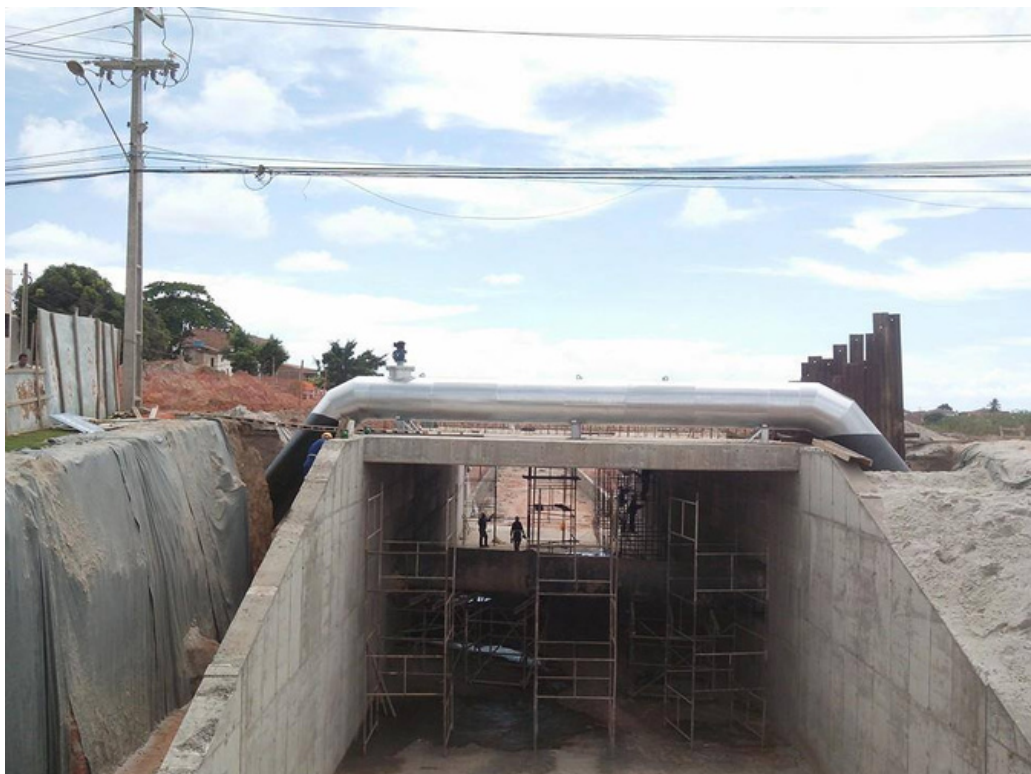
Travessia Aérea Auto-Portante DN 1000mm | Maceió/AL
