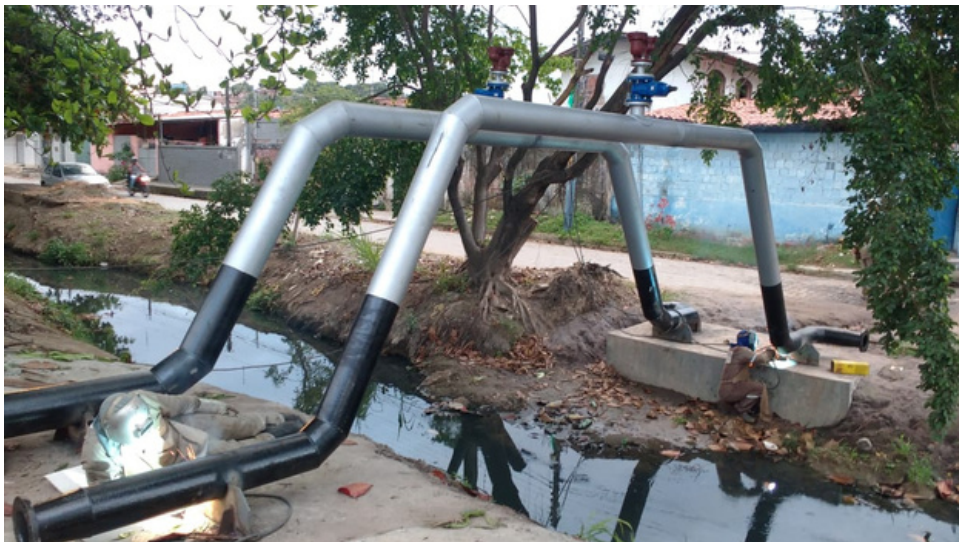
Travessias Auto-Portantes DN 250 mm, Olinda/PE
