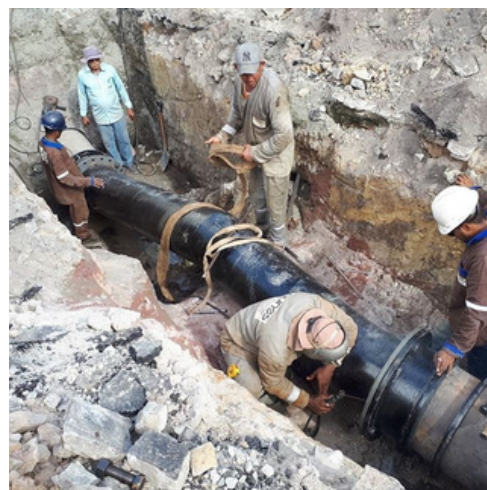
Interligação na Adutora de Recalque DN 500mm
