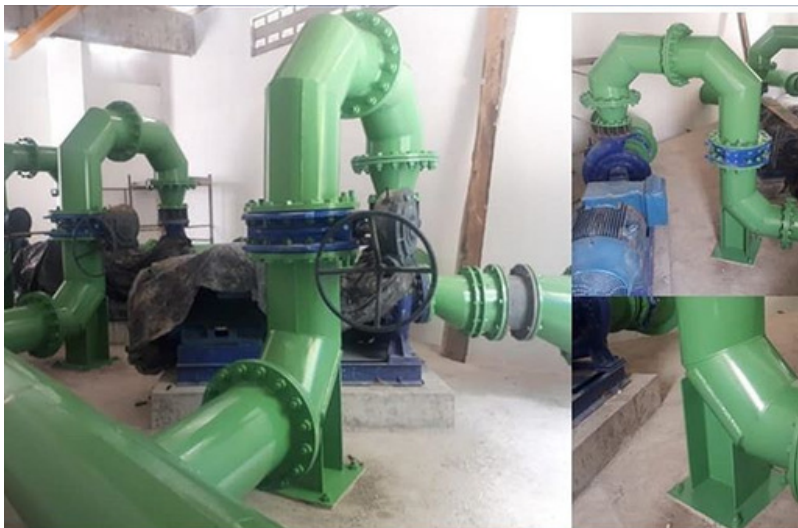
Implantação de Estação de Bombeamento
