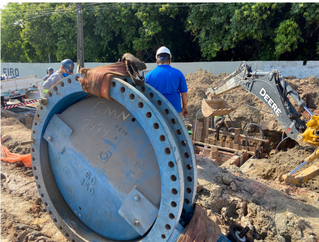
Ação de melhoria realizada na Adutora de Água Tratada DN 1500mm do Sistema Tapacurá | 2021 Instalação de Válvula Borboleta DN 1500mm. com fornecimento de conexões de adaptação.
